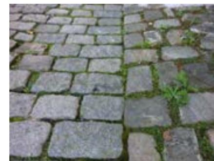
Exemple de revers pavés semi perméables aux abords des murs écartant les eaux de ruissellement
