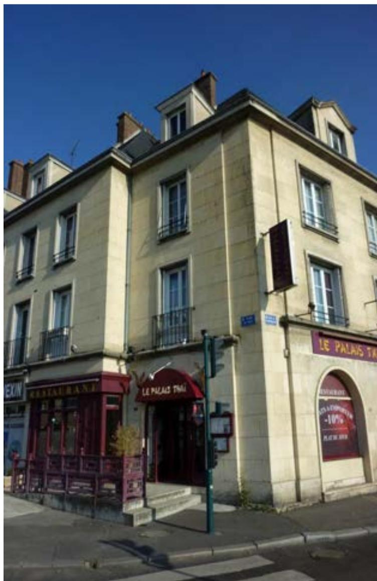
Les caractéristiques principales sont: une architecture sobre, réalisée à partir de maçonneries en pierre calcaire, de baies adaptées aux types de pièce, d'un comble à 2 pentes avec lucarnes à croupe ou à fronton quai du Pothuis
