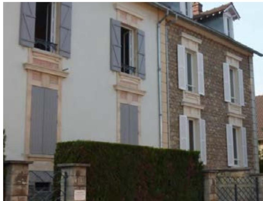
À gauche: façade ayant conservé son enduit. A droite: les maçonneries hétérogènes autrefois protégées par un enduit ont été mises à nu.
