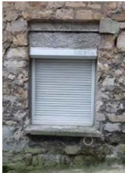
Modification radicale de la façade due à la réduction de l'ouverture et à la pose de ce volet roulant en PVC à coffre extérieur
