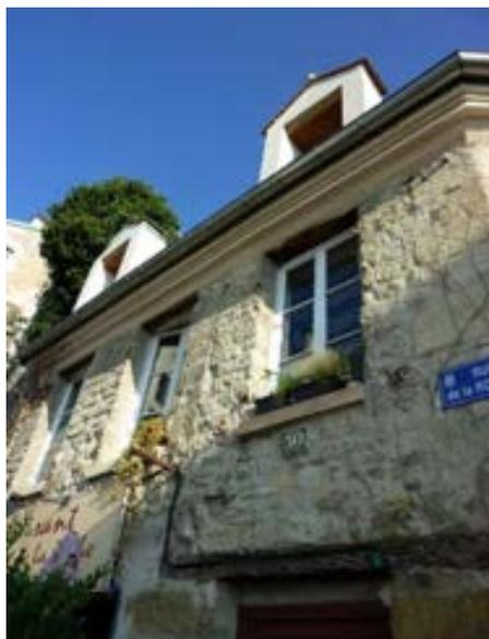
Maçonneries mises à nu et fortement dégradées (piochage des enduits, gel, pluies, etc...)
