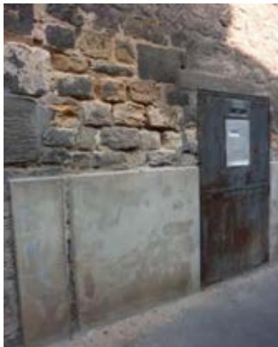
Soubassement en ciment accentuant la dégradation des pierres
