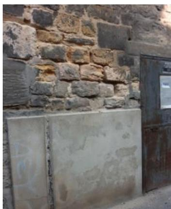
Application d'un enduit ciment sur pierres de taille ayant entraîné la dégradation de la pierre
