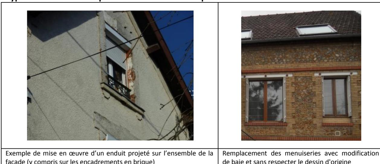
Exemple de mise en œuvre d'un enduit projeté sur l'ensemble de la façade (y compris sur les encadrements en brique)
