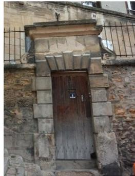
Exemples de percements ménagés dans des murs de clôture: la baie est surmontée d'une partie pleine maçonnée assurant la continuité du mur sur sa partie supérieure.
