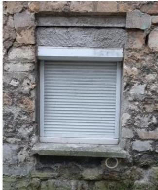
Modification radicale de la façade due à la réduction de l'ouverture et à la pose de ce volet roulant en PVC à coffre extérieur
