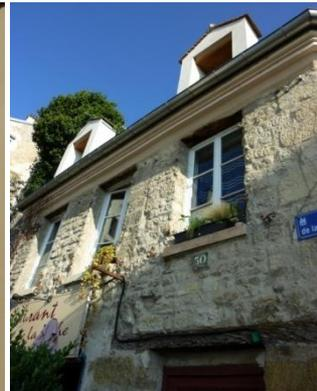
Maçonneries mises à nu et fortement dégradées (piochage des enduits, gel, pluies, etc...)
